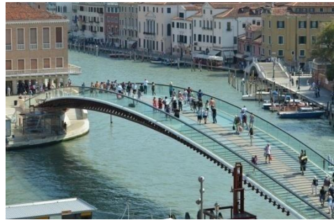
PONTE DE CALATRAVA
